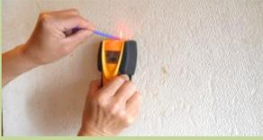
検知器で壁の中の木下地を探します
